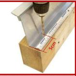
Bohren Sie den Alu-Wandanschluss. Der Bohrdurchmesser richtet sich nach den verwendeten Schrauben. Die erste Bohrung erfolgt nach ca. 5 cm, die folgenden Bohrungen immer in einem
