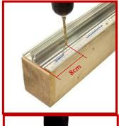
Profilunterteile im Abstand von 35 cm links und rechts vom Mittelsteg im Wechsel vorbohren (Ø 5 mm). Der Abstand der ersten Bohrung zur vorderen Kante beträgt 8 cm.
