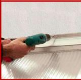
Verschrauben Sie das Profil mitgeeigneten Schrauben.
