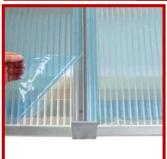
Legen Sie die Platte auf und richten Sie winkelgerecht aus. Plattenabstand 25 mm. Die gekennzeichnete Schutzfolie nach oben - UV-Schutz!
