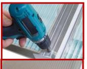
Nacheinander immer zwei Platten auflegen, ausrichten und fixieren. Profiloberteile Rand und Mitte auflegen und Edelstahlschrauben (Metall6,3x 32 mm) oder Bohrschrauben (5,5 x34 mm) mit dem Unterteilen verschrauben. Fortfahren Bis zur letzten Platte. Diese dann einmessen, ggf. zuschneiden und mit Randprofil montieren.
