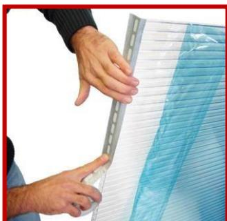
Bringen Sie das passende Kantenverschlussband am Ende der Platten an. Es verhindert das Eindringen von Staub, Schmutz und Insekten. Die Membranversion lässt gleichzeitig die Lüftung der Hohlkammern zu.
