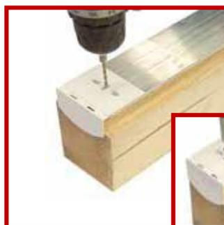
Bohren Sie den Abschluss und Haltewinkel mit einem Bohrdurchmesser von 5 mm vor. Abstände zur Biegekante: 20 und 40 mm.
