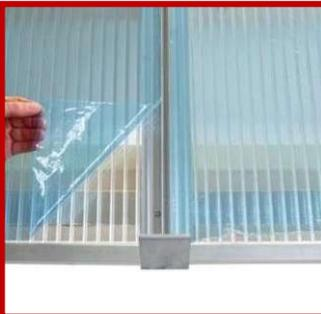
Legen Sie die Platte auf und richten Sie diese winkelig aus. Plattenabstand 28 mm. Die gekennzeichnete Schutzfolie nach oben - UV-Schutz!
