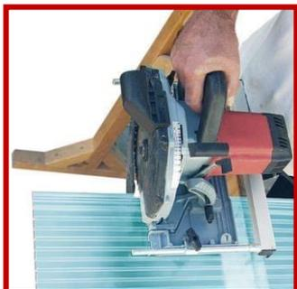
Schneiden Sie die Platten auf Endlänge. Berücksichtigen Sie hierbei einen ausreichenden Traufüberstand. Sägespäne in den Hohlkammern mit Druckluft oder Staubsauger entfernen.
