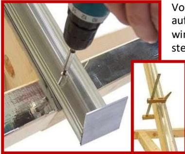
Vorbereitete Profilunterteile auflegen. Abschluss- und Haltewinkel können komplett überstehen (Wenn nicht möglich in den Sparren ausklinken). Profile exakt ausrichten, mit Zwingen fixieren und verschrauben.
